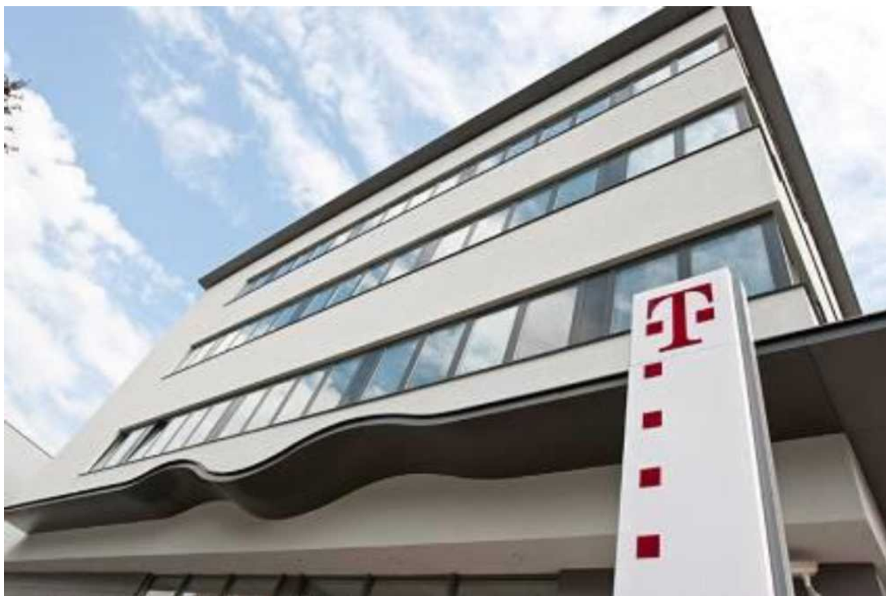
Obrázok 6 DC Telekom Datacenter
